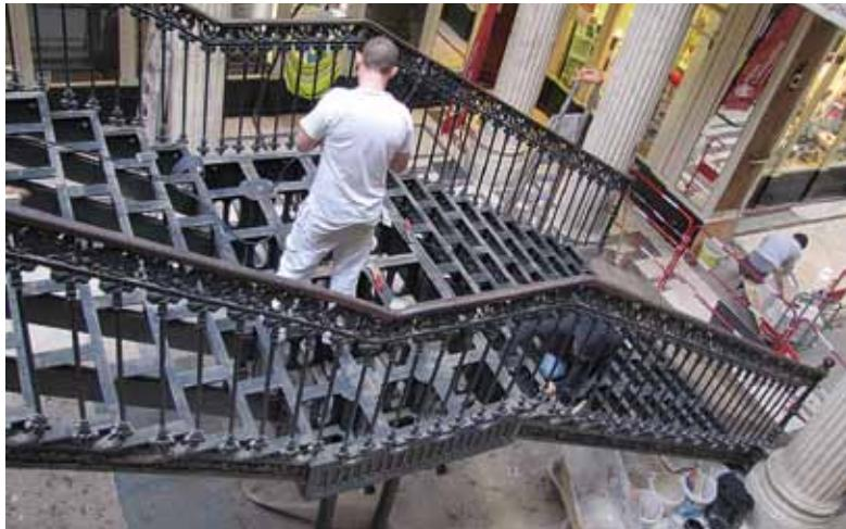
*Structure métallique de l'escalier révélée à l'occasion de la dépose des marches de bois.*
