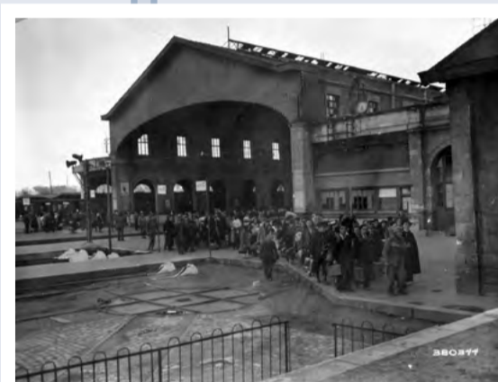
La Seconde Guerre mondiale : cette photographie prise au moment de l'arrivée de réfugiés le 30 octobre 1944, permet d'observer l'état de la halle métallique. Elle est alors recouverte sur ces deux pignons de lambris. Elle sera démantelée 5 ans plus tard. Les gares de Nantes et les voies ferrées ont été lourdement endommagées par les bombardements de la ville.
