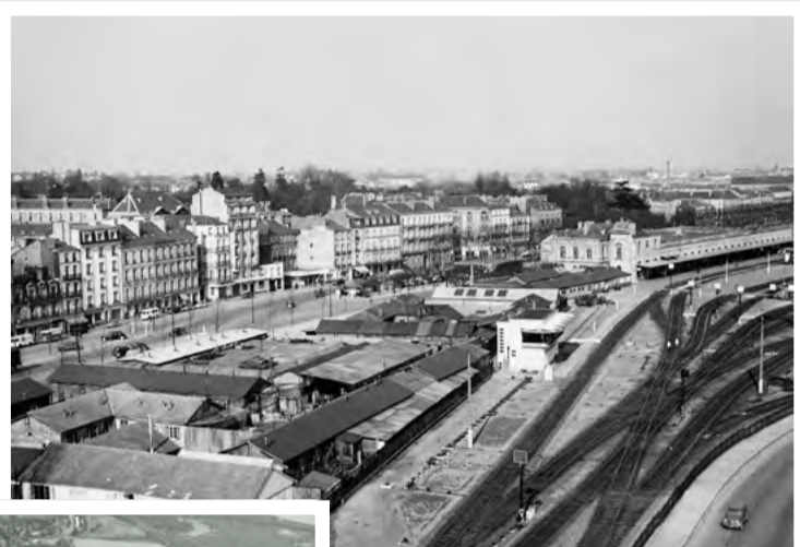
18 mars 1955 : quelques bâtiments issus de la gare du 19 e siècle sont encore visibles, également une des statues et l'horloge de la cour des départs. Le poste d'aiguillage date de 1941. La grande halle métallique a été démolie dès 1949.
