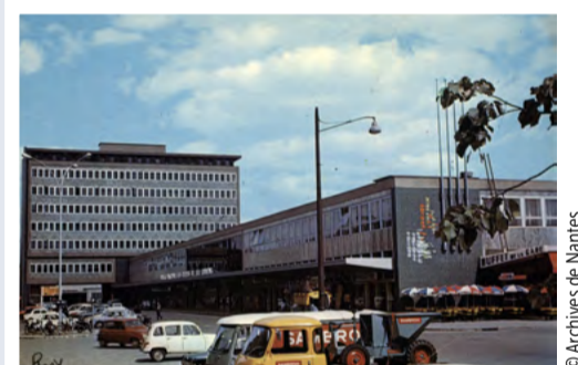
Esplanade de la gare de Nantes, avril 1979. La façade du bâtiment voyageurs est d'une grande simplicité. Elle comporte un revêtement de marbre vert du Portugal en allèges et des baies en menuiserie d'aluminium.
