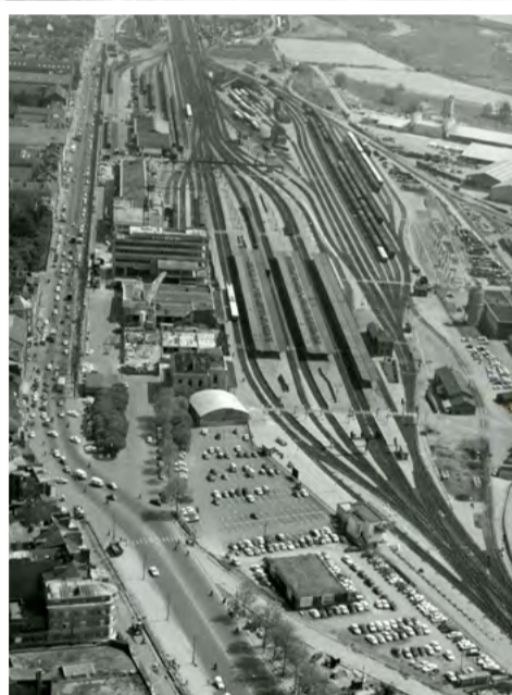
La gare de 1969 est en construction, les travaux ne sont pas achevés. Le pavillon nord-ouest, en pierre, sera le dernier démolé.
