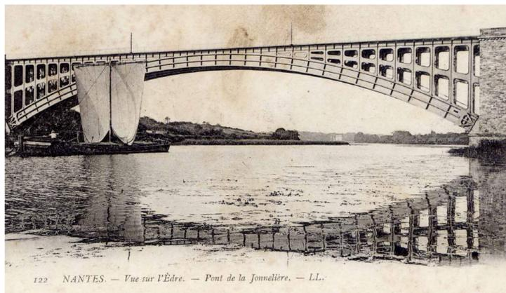
▲ 1877 : La ligne de chemin de fer Nantes-Châteaubriant est ouverte. À la Jonelière, les trains traversent l'Erdre sur un viaduc métallique (détruit en 1944). Sur l'Erdre, le transport de marchandises est encore important.
