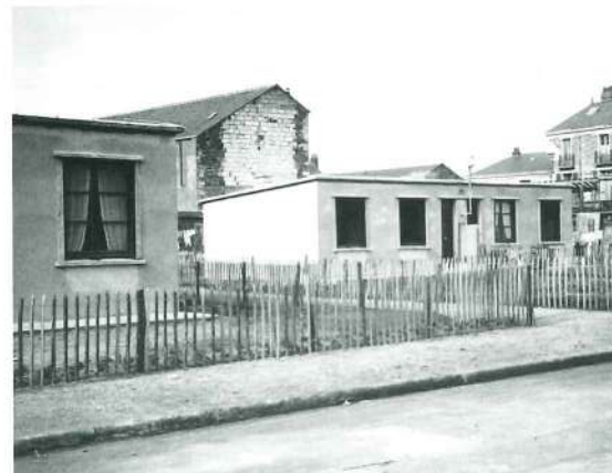
Les rues de la Pilotière en construction
