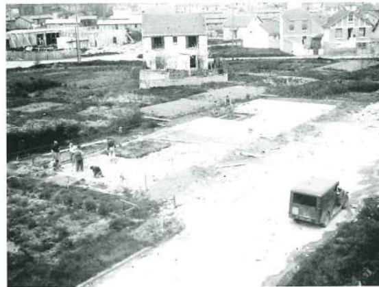
Les rues de la Pilotière en construction
