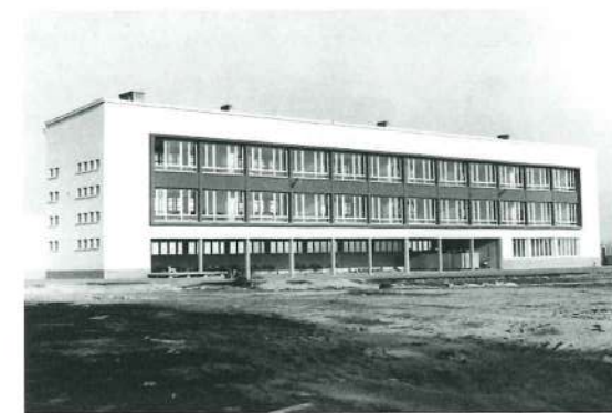
Construction de l'école Urbain Le Verrier, 1958
