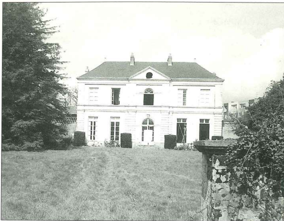
2 Le Château du Croissant avant sa démolition.
